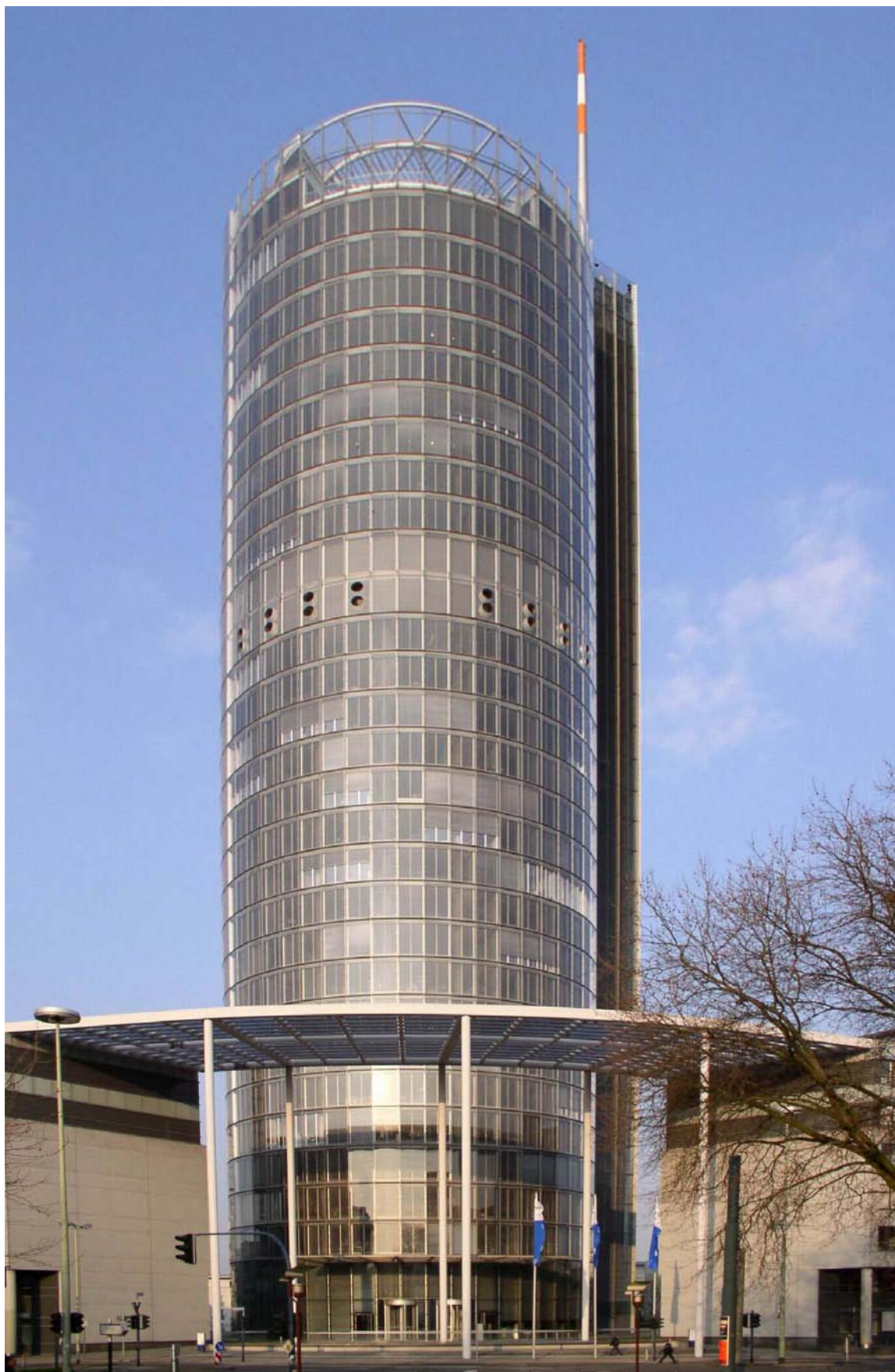
RWE Essen irodaház Ingehoven Overdiek und Partner 1996 30 meletes, 163 méter magas, 32 méter átmérőjű. Egyszintes panelek 1970x3461 mm fehérüveg, 500 mm távval. Vegle Glas
